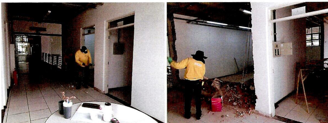
Fotos da demolição
