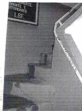
Foto 10- Vista do acesso ao segundo pavimento. Município de Santa Rita do Sapucaí - MG Raquel Córdova Christófaro, outubro/ 2011
