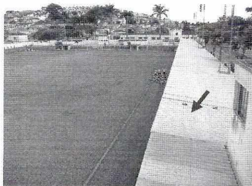
Foto 02- Vista geral do campo e detalhe da cobertura da arquibancada.
