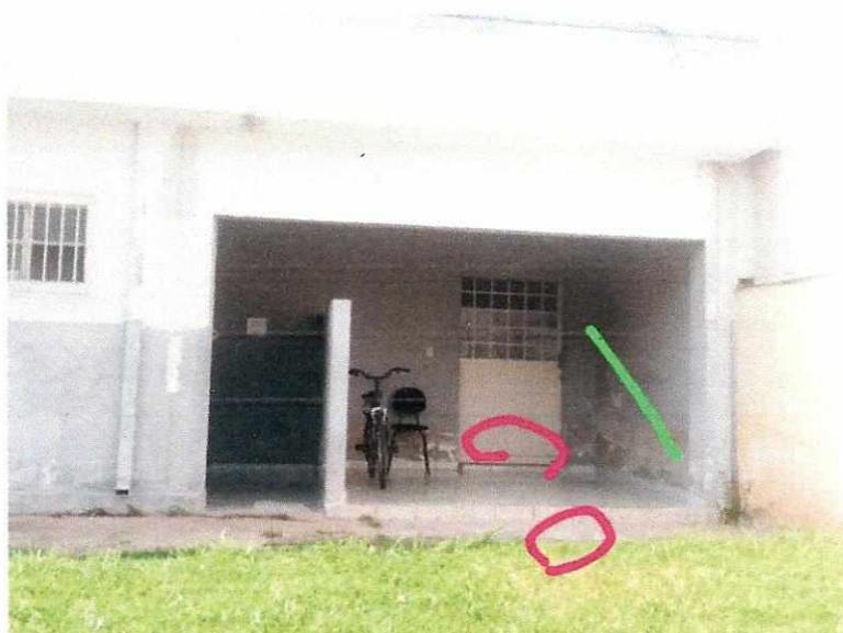
Rampa de acessibilidade e corrimão
