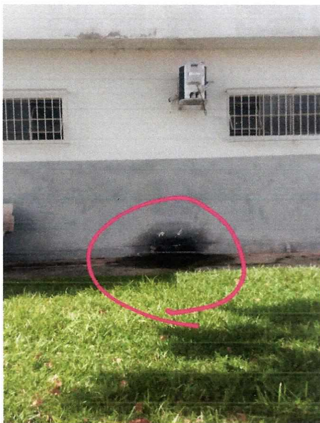
Colocar mangueira no ar condicionado
