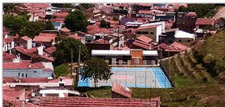
Trocar telas danificadas
